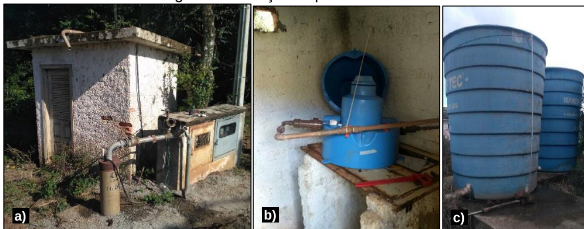
Figura 47 – Poço Vespasiano Correia.
