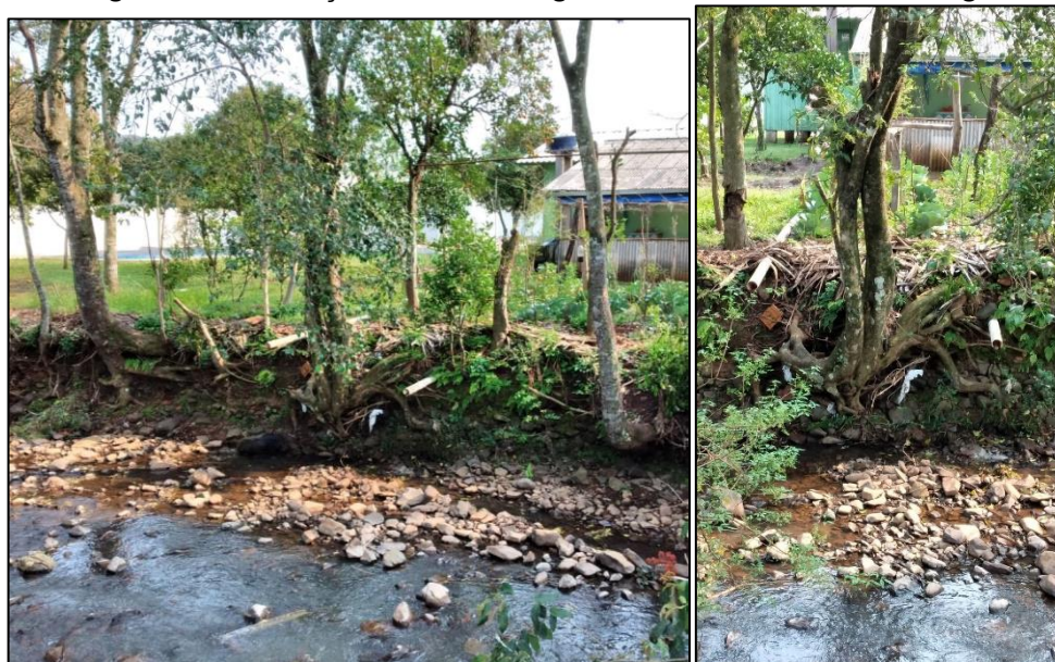
Figura 70 – Lançamento de esgoto bruto no Arroio Porongo
