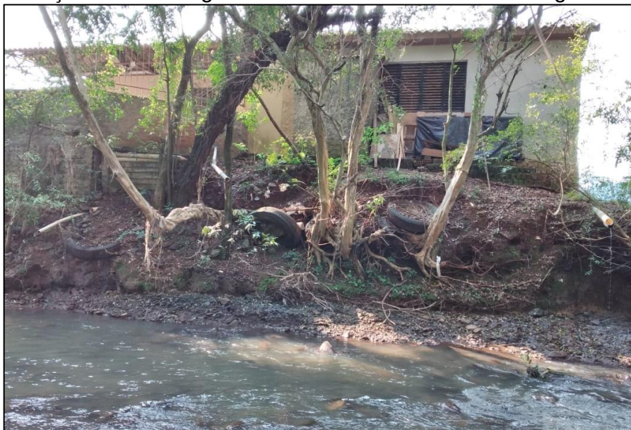
Figura 72 – Lançamento de esgoto bruto no Arroio Tarimba – margem Campo do 15.
