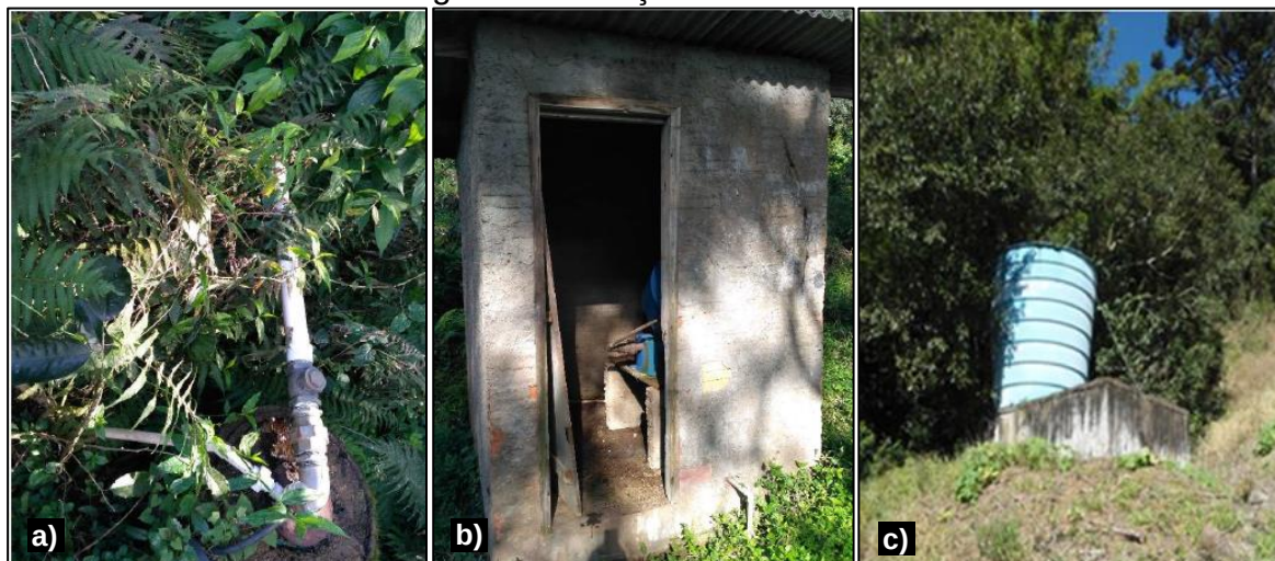
Figura 46 – Poço Moinho Zanetti
